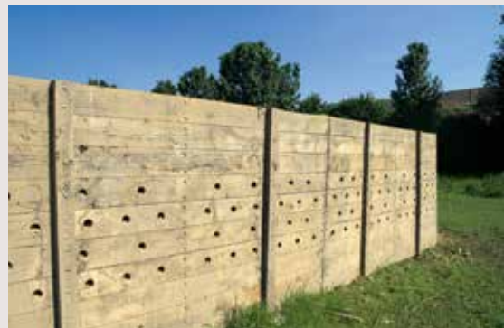
Figure D : front artificiel aménagé pour l'Hirondelle de rivage au niveau de délaissés ou sur l'emprise réaménagée. © Y.Capon/Biotope
