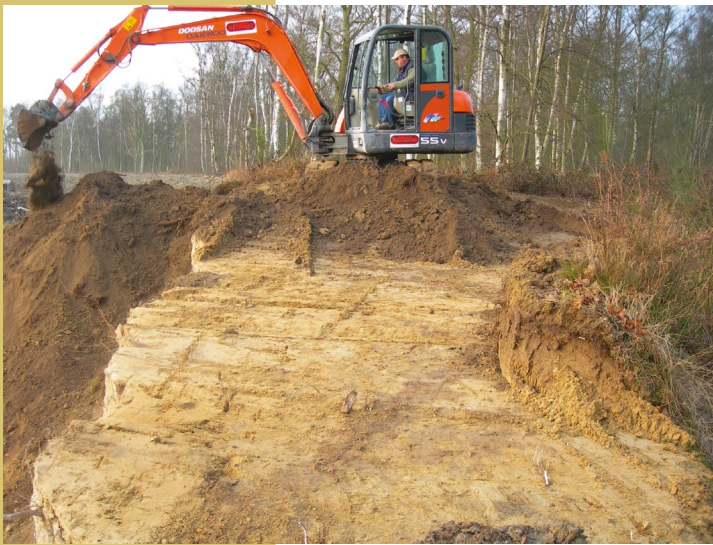
Décapage de la terre pour mettre en surface un substrat sableux pour les abeilles solitaires.
