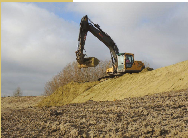
Création de talus
