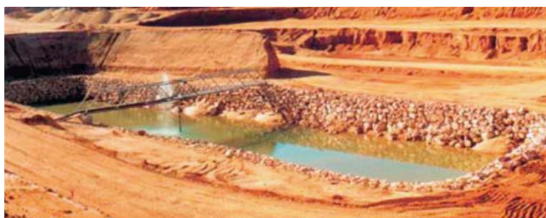
Balsa de decantación - Gravera - Explotación El tomillar - Hormisoria, S.A. - España
