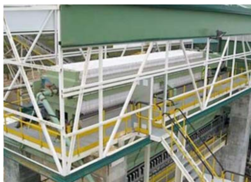
Filtro prensa – Proceso de deshidratación de lodos y recuperación de aguas residuales.
