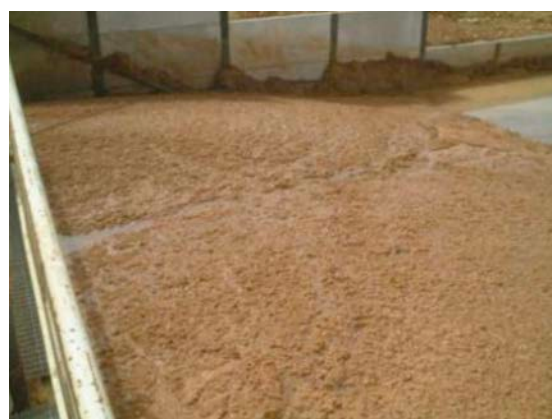
Compartimentos de decantación de lodos en hormigón forzada con floclulantes – FdA – España
