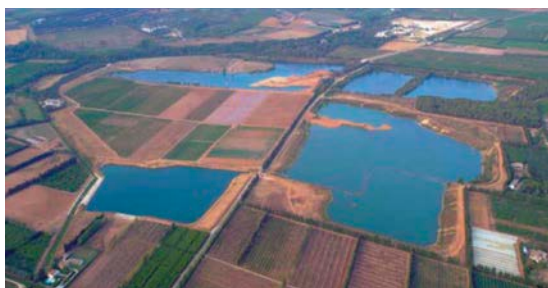
Gravera – Explotación de Bellegarde – Lafarge – Francia
