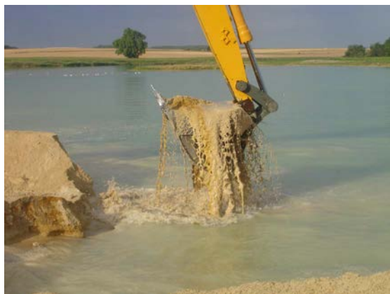
Extracción de áridos bajo el nivel freático – UNICEM
