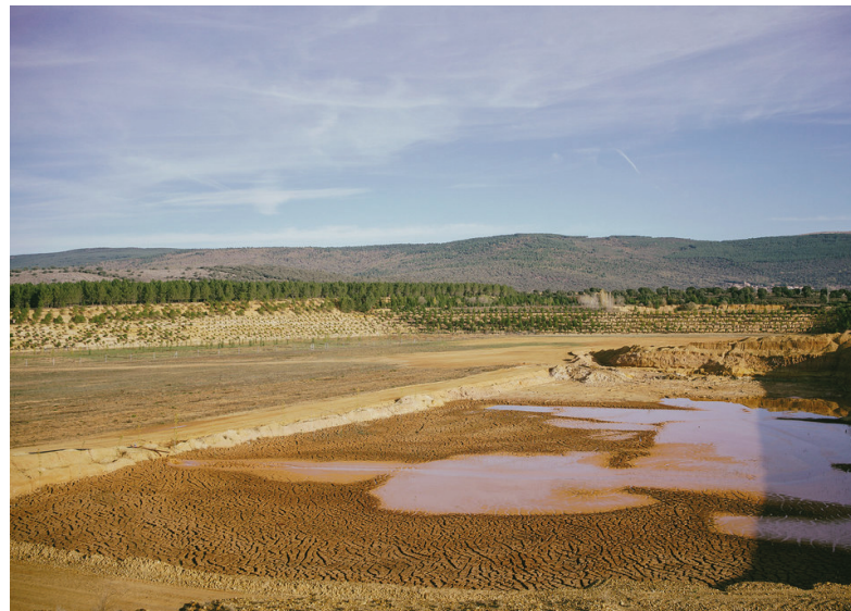
Schrittweise Wiederherstellung einer Abbaustätte für Gesteinskörnungen mit Geländevorbereitung zur Förderung der Wiederherstellung von Lebensräumen. [5]
